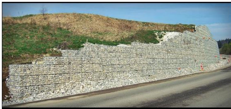
Рис. 3. Укріплення природніх укосів габіонами
