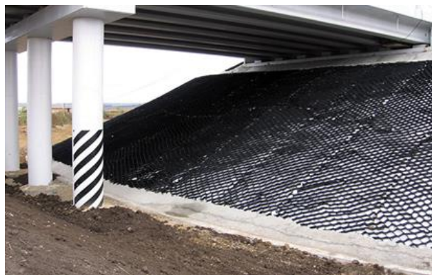
Рис. 1. Укріплення укосів та конусів шляхопроводів георешіткою
