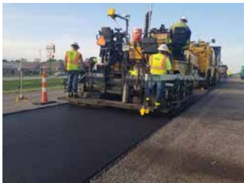
Рис. 1. Процес укладання асфальтного покриття [1]
