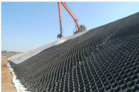
Рис. 1. Укріплення укосів та конусів шляхопроводів георешіткою
